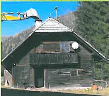
Altbestand wurde entfernt (Thomele-Keusche)
