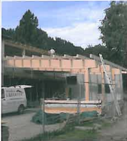
Bauhofzubau in gelungener Beton- und Holzkonstruktion
